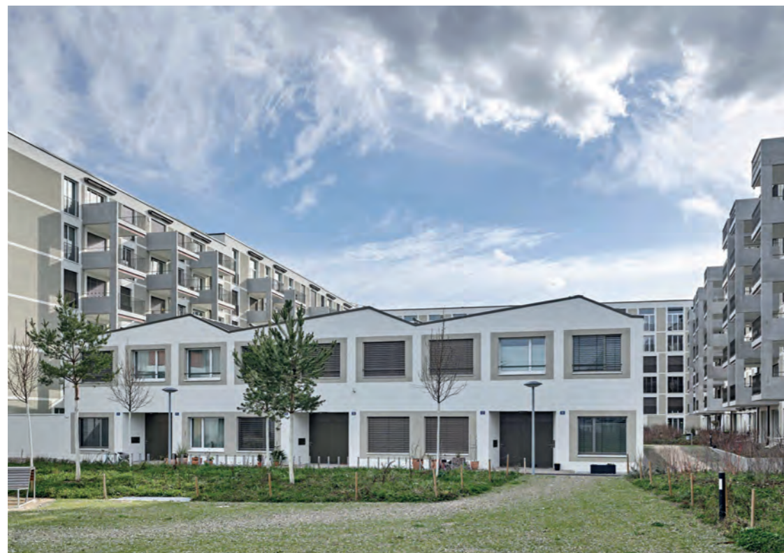
Erlenmatt West, Innenhof Baufeld E mit Reiheneinfamilienhäuser
